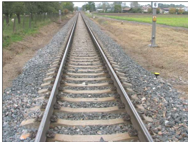
Úsek s kolejí po opravě, polopružné upevnění Ks
