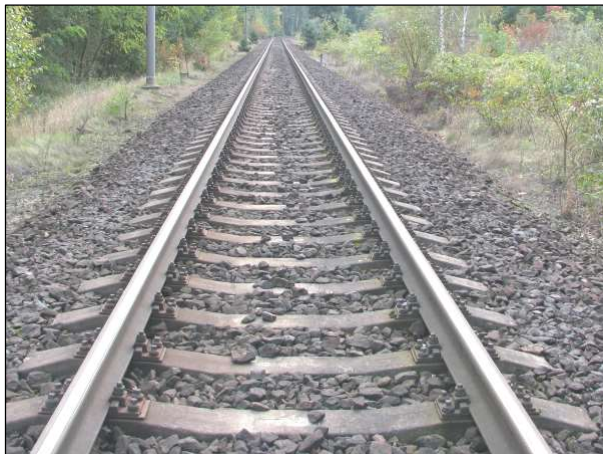
Úsek s tratí v původním stavu, tuhé upevnění K
