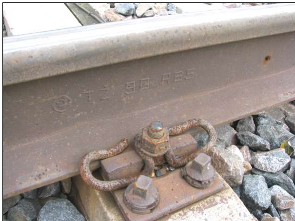
Detail železničního svršku, polopružné upevnění Ks
