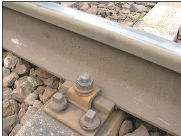
Detail železničního svršku, tuhé upevnění K
